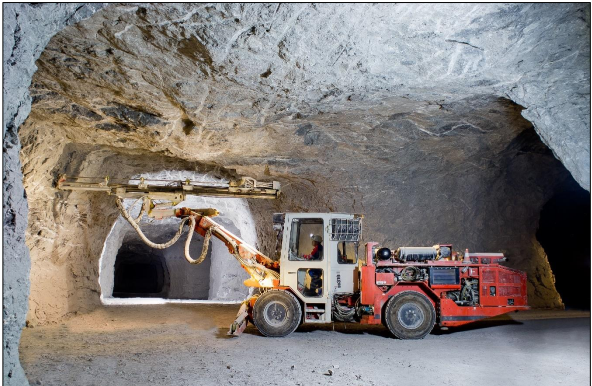
Abbildung 28: Bohrwagen in der Grube Breitestein [BGR 2025, mit freundlicher Genehmigung der Knauf Gips KG]
