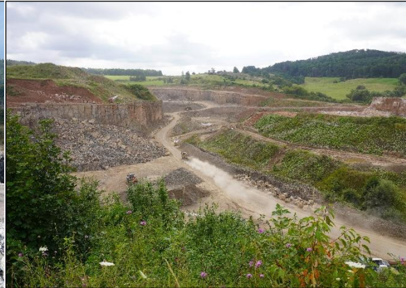
Abbildung 23: Gipsbruch Kipphäuser Berg [BGR 2025]
