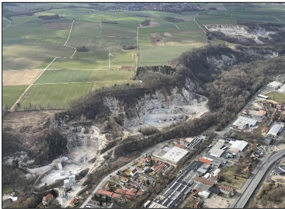
Abbildung 18: Luftbild der Gipsbrüche bei Osterode [BGR 2025]
